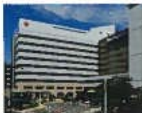
名古屋第二赤十字病院様 病院等から出る紙オムツ、 生ごみ等(一般ごみ)
